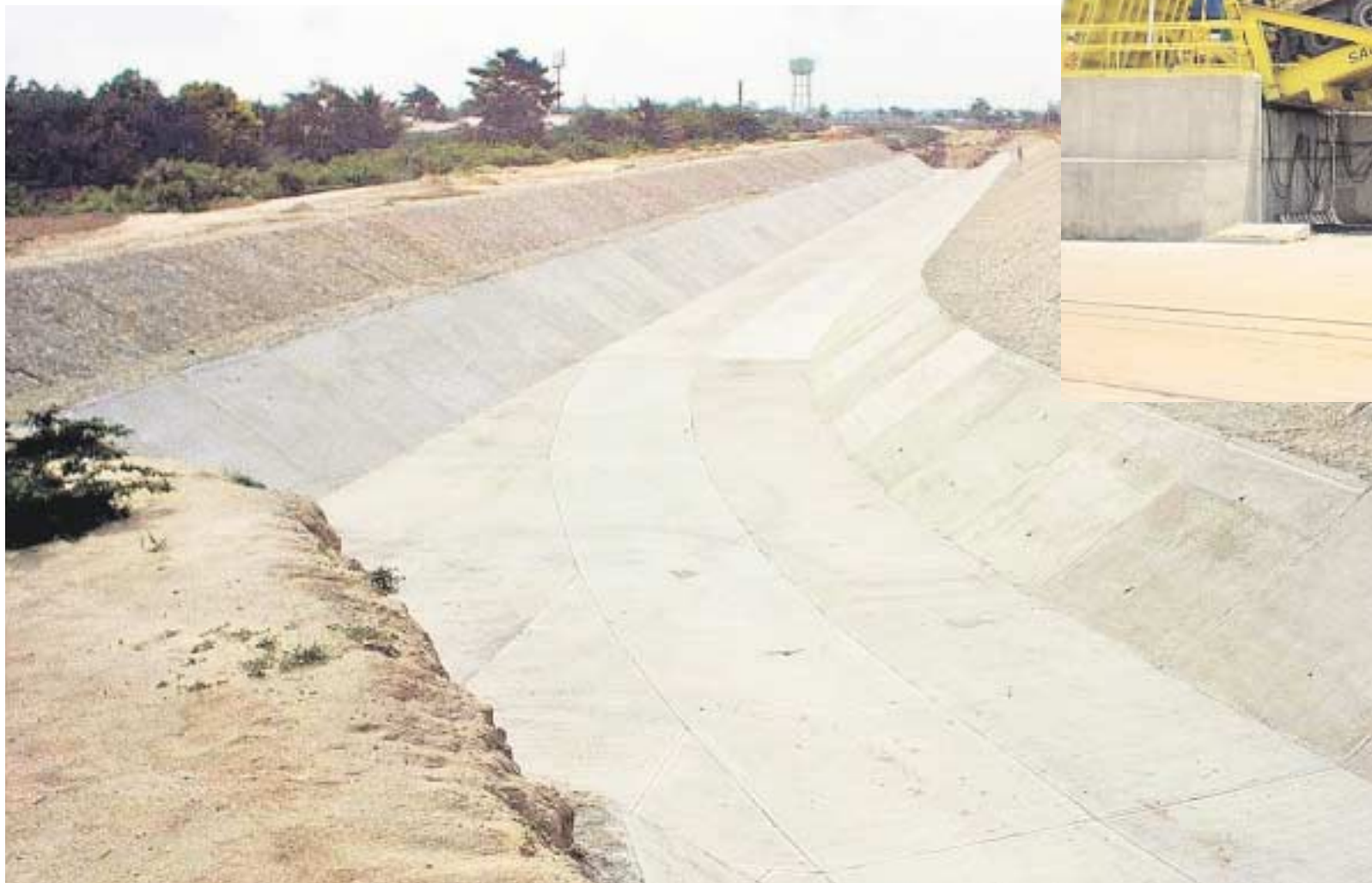
Panorámica del canal terminado para el arroyo El Platanal en el municipio de Soledad.
